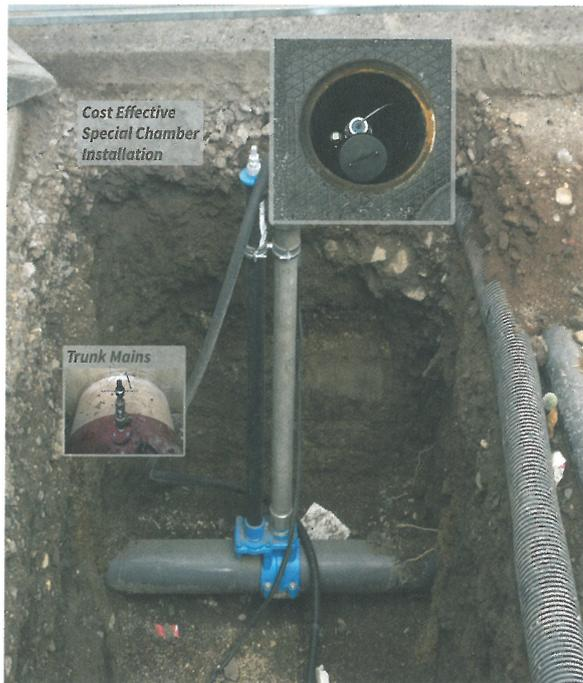
Bild 4: Anbauselle mit Sensor und Einbau mithilfe eines Sensor-Schacht-Moduls
